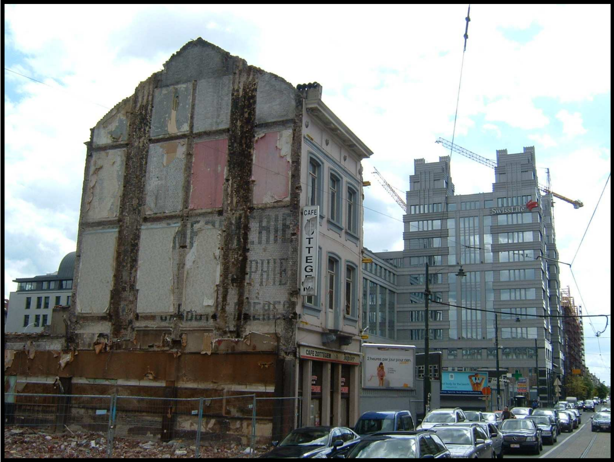
Figure 2. Destruction d'un quartier populaire et nouveaux complexes de bureaux face à la gare TGV du Midi (photo M. Van Criekingen).
